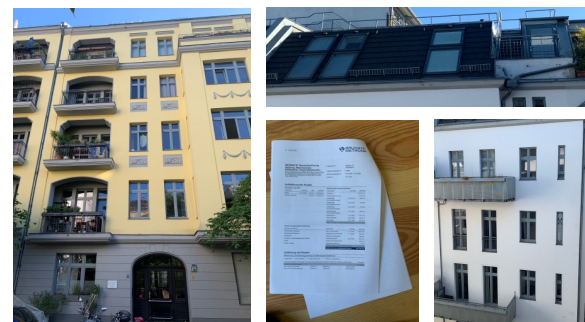
Abbildung 5: Berliner Altbaugebäude in Berlin-Pankow für die Validierung am Einzelgebäude. Links: Straßenseite, oben rechts: ausgebauter Dachgeschoss; unten Mitte: Heizkostenabrechnung, unten rechts: Hoffassade
